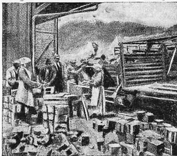
Литье кубиков из доменного шлака. На снимке — сортировка готовых кубиков
